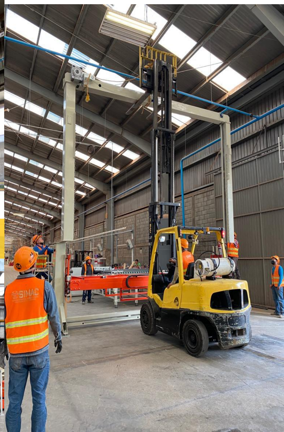
Montaje de Cargadoras y Descargadoras SITI de recubrimiento cerámico Planta Pavillion
