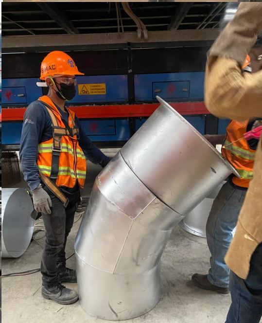
Modificación de tubería de aire caliente HORNO BICANAL SITI para librar la línea directa que causaba interferencia
