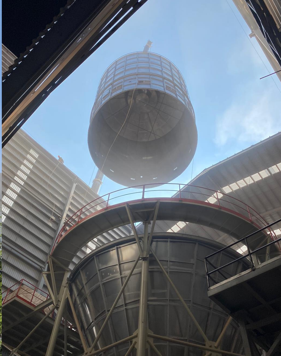
Montaje ATM Grúa 350 Ton
