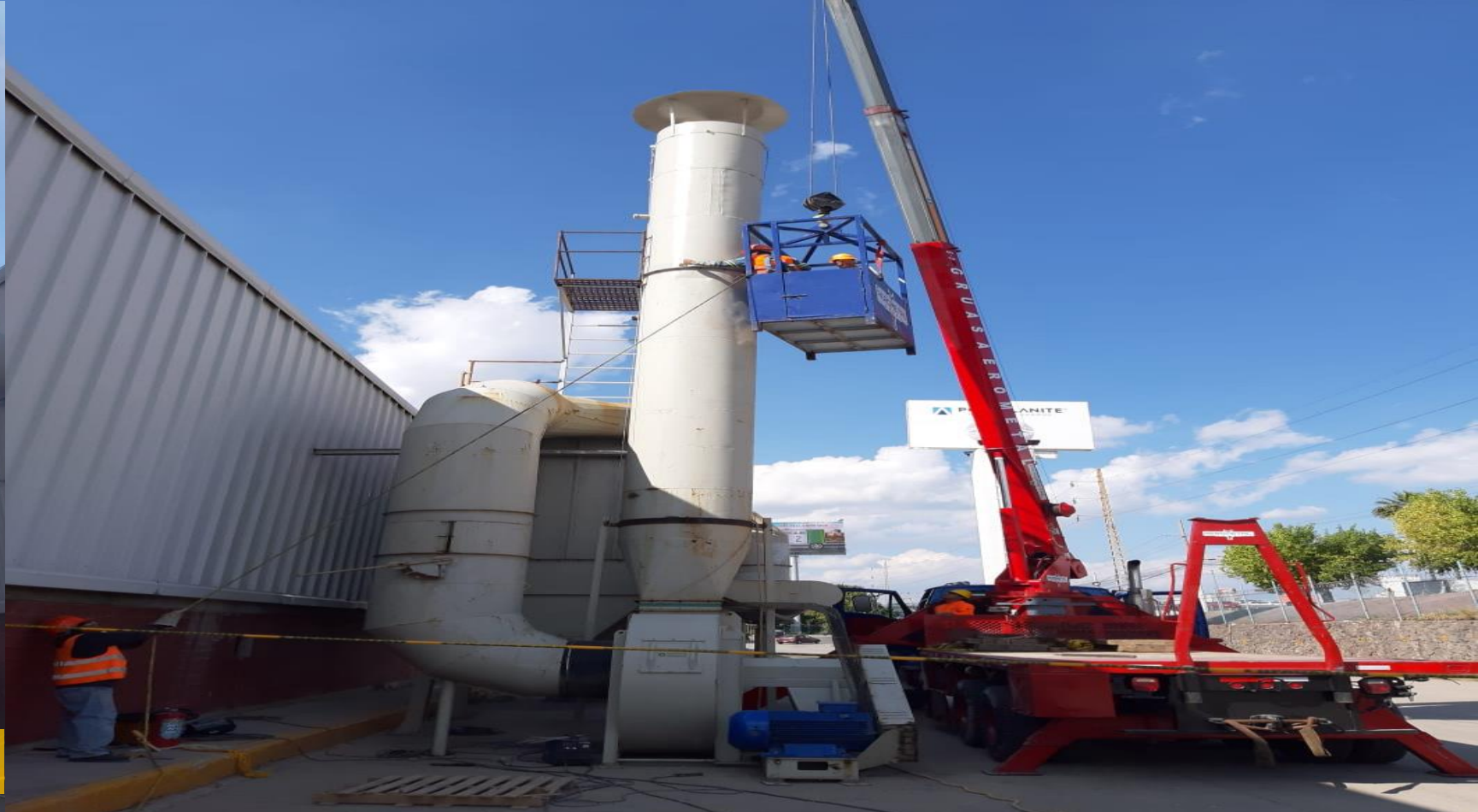
Fabricación e instalación chimenea colector de polvos
