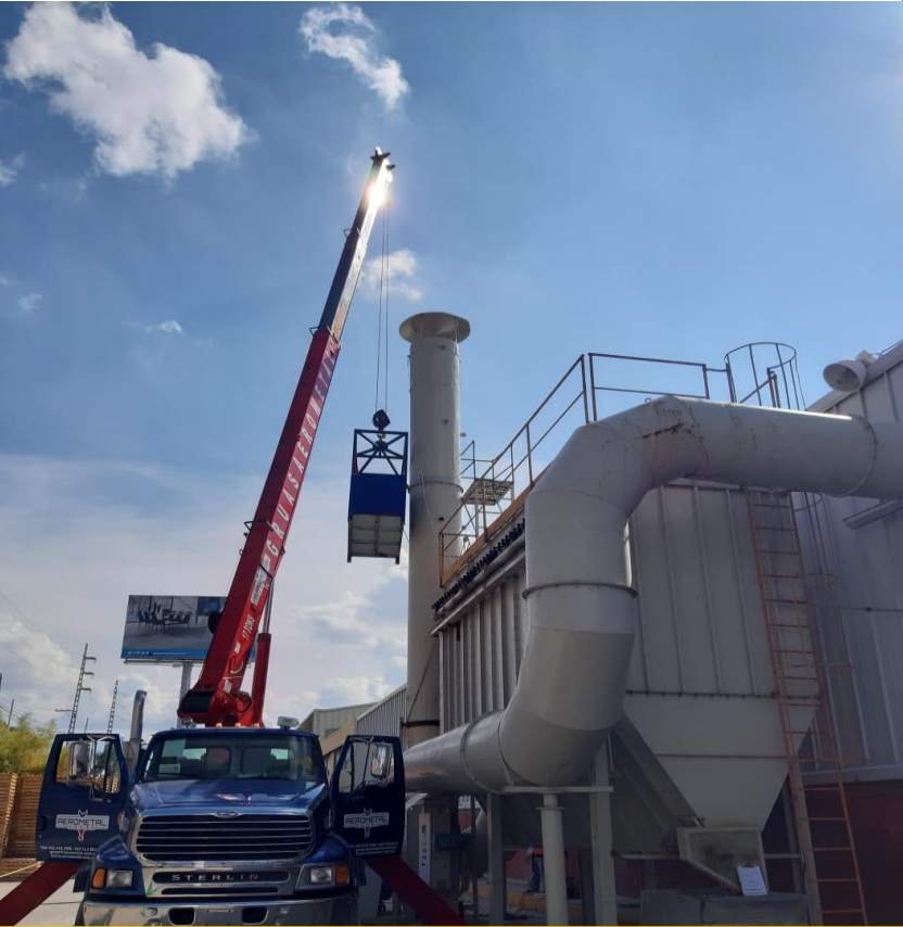
Fabricación e instalación chimenea colector de polvos
