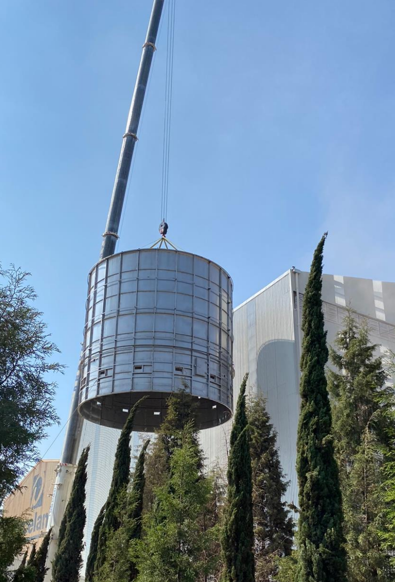
Montaje ATM Grúa 350 Ton
